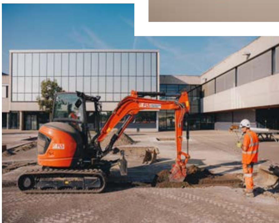
Travaux de "déminéralisation" au collège Nelson Mandela à Noé pour l'aménagement de la cour oasis
