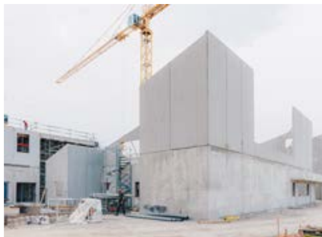
Travaux du chantier de construction du collège d'Aucamville
