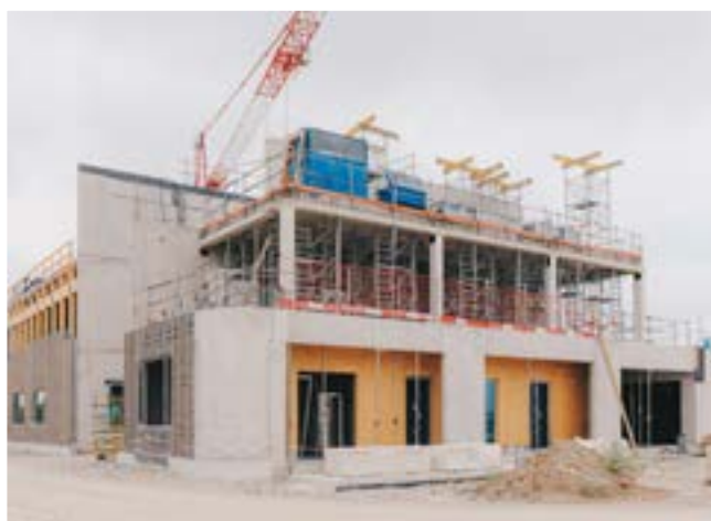
Travaux du chantier de construction du collège de Plaisance-du-Touch
