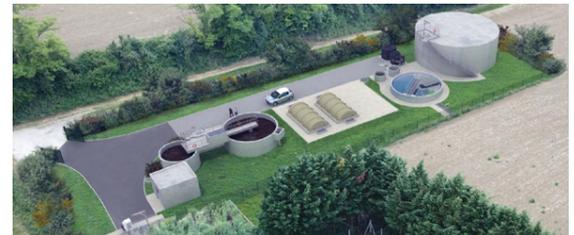
Reconstruite à proximité immédiate de l'ancien ouvrage, en dehors de la zone inondable, elle utilise la technologie de traitement des eaux usées de type biodisque (circulation des eaux usées sur de grands disques en rotation supportant les bactéries en charge de dépolluer ces eaux usées).
